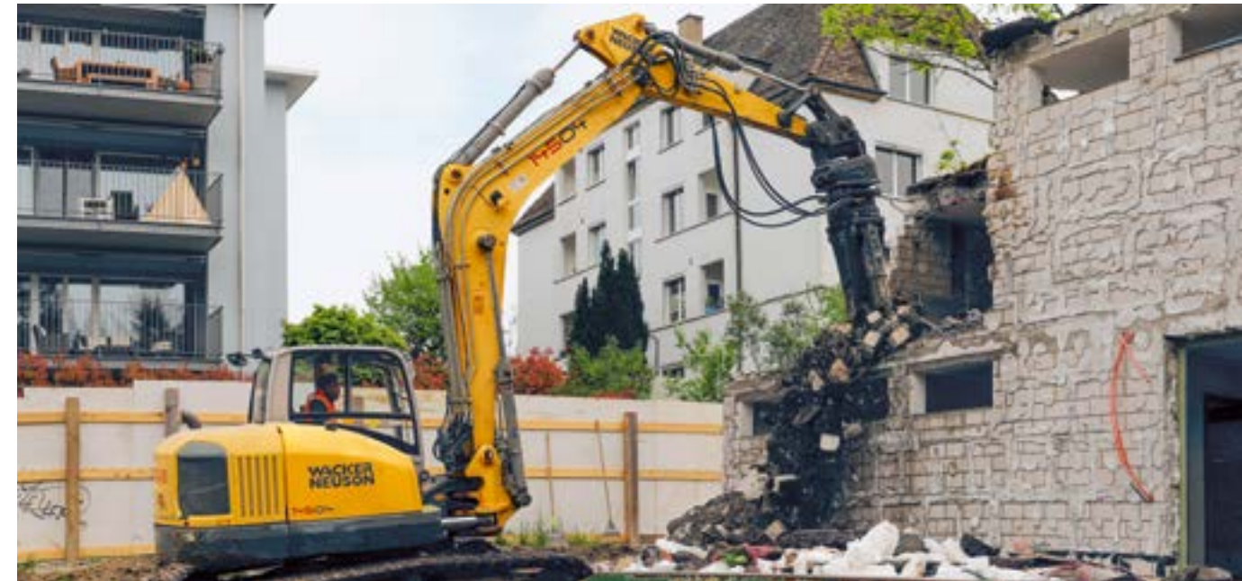
Der Bagger fuhr auf und leistete «ganze Arbeit». // Bild Michael Baer
