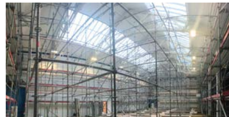
Imposante Gerüst-Konstruktion im Halleninnern.
