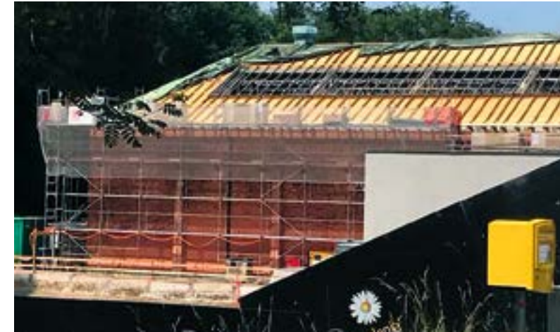
Aussenansicht der Halle während der Renovation.
